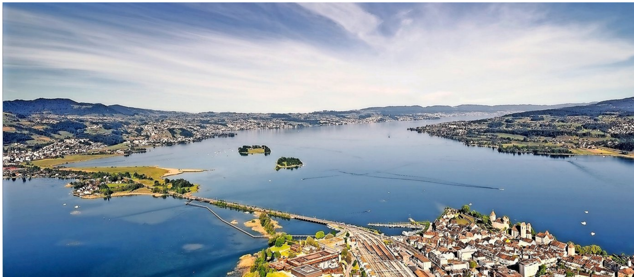
Der Stadttunnel unter Rapperswil-Jona würde auch die Stausituation auf dem Seedamm vermindern.
